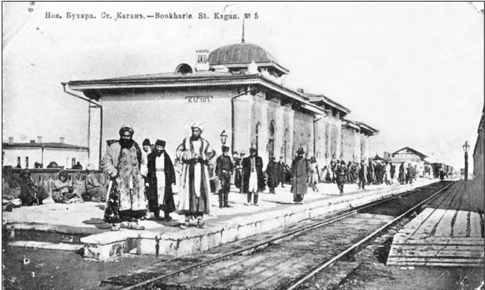
В 1887 г. через территорию Бухарского эмирата была проложена первая железная дорога.
